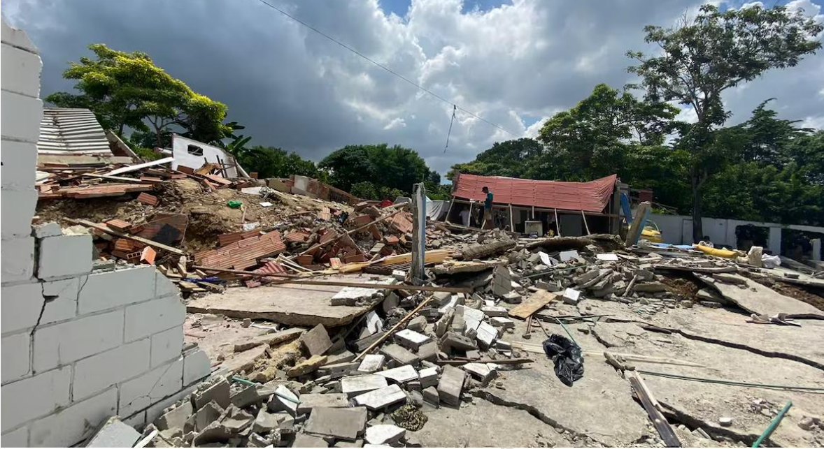
Figura 1.63. Deslizamiento Barrio La Manga septiembre 2022
