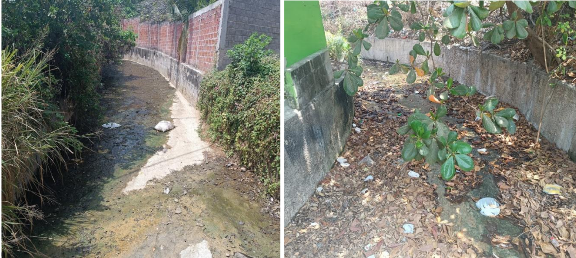
Figura 1.49. Canalización Arroyo San Lorenzo
