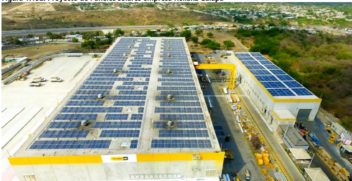
Figura 1.152. Proyecto de Paneles solares empresa Relianz Galapa
