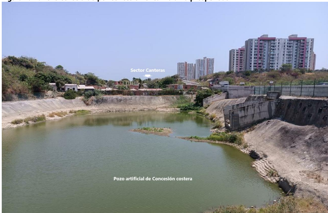
Figura 1.27. Pozo construido por concesión circunvalar la prosperidad
