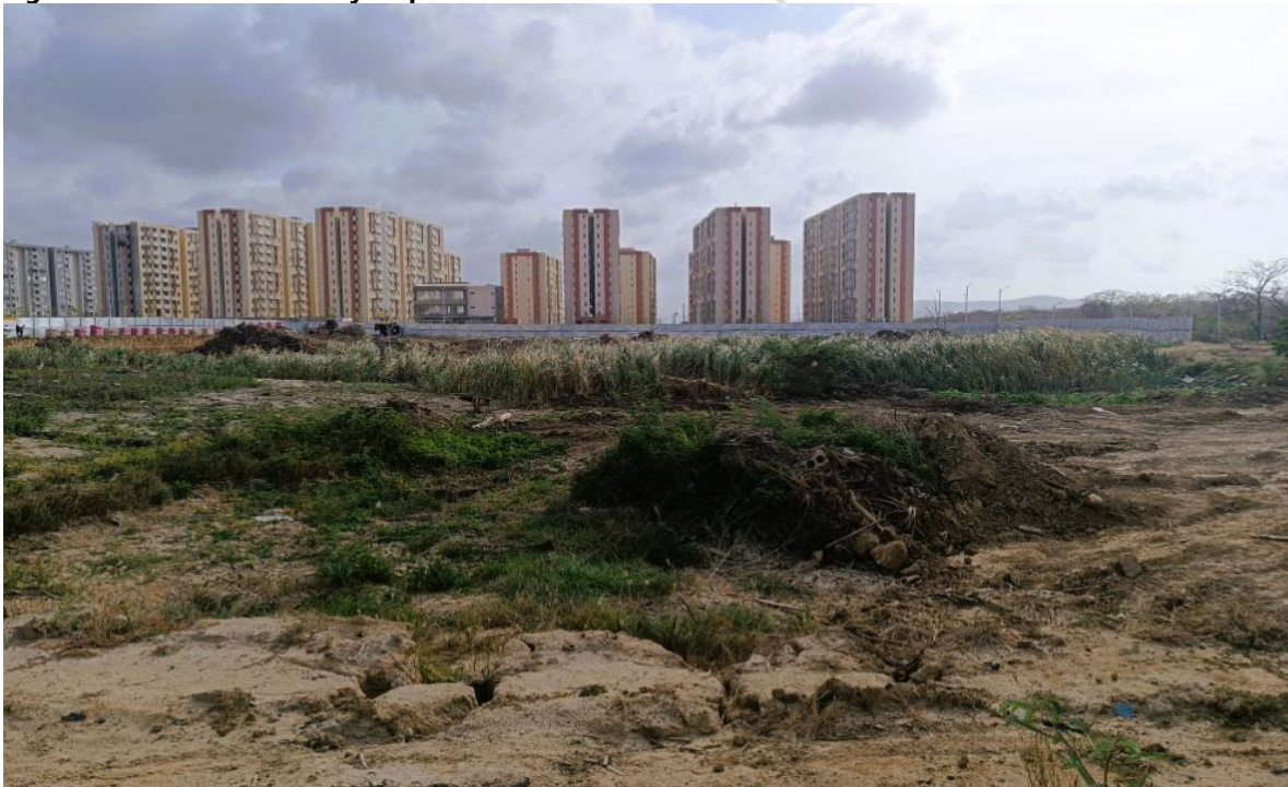
Figura 1.11. Lotes drenados y en proceso de relleno Alameda del río
