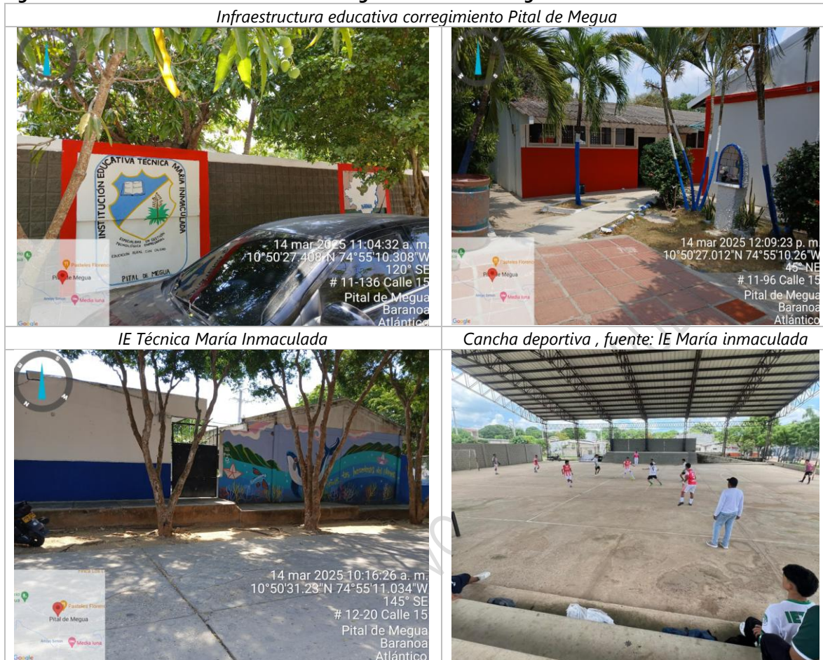
Figura 1.111. Infraestructura educativa Corregimiento Pital de Megua
