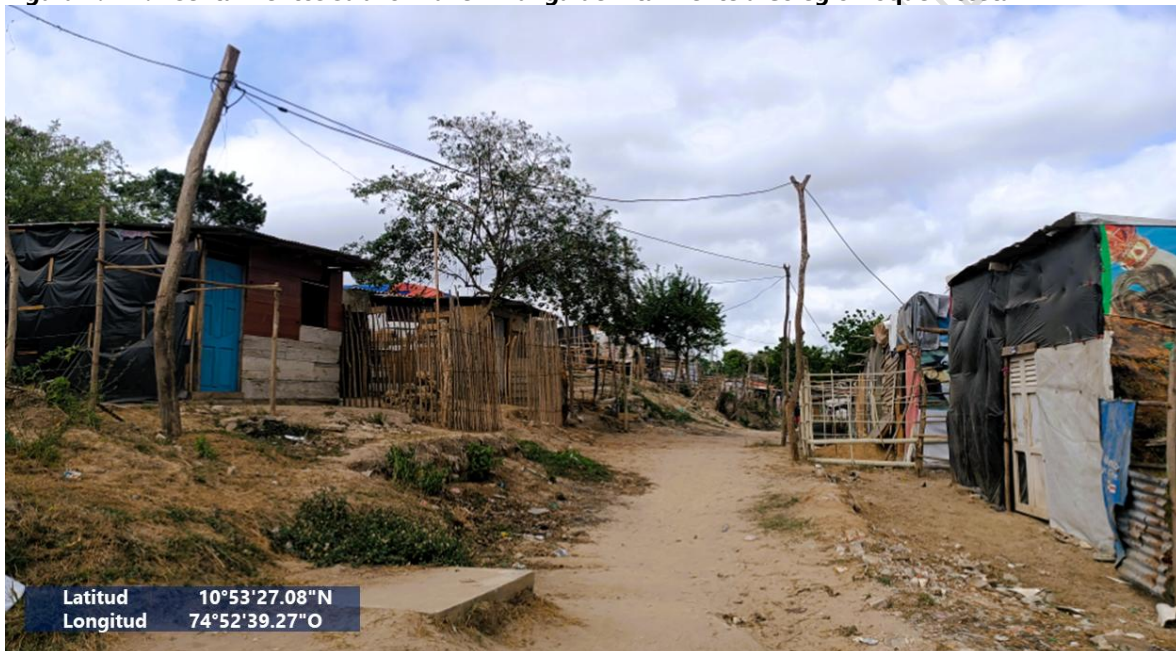
Figura 1.121. Asentamientos subnormal en Manga de Pital frente a Colegio Roque Acosta
