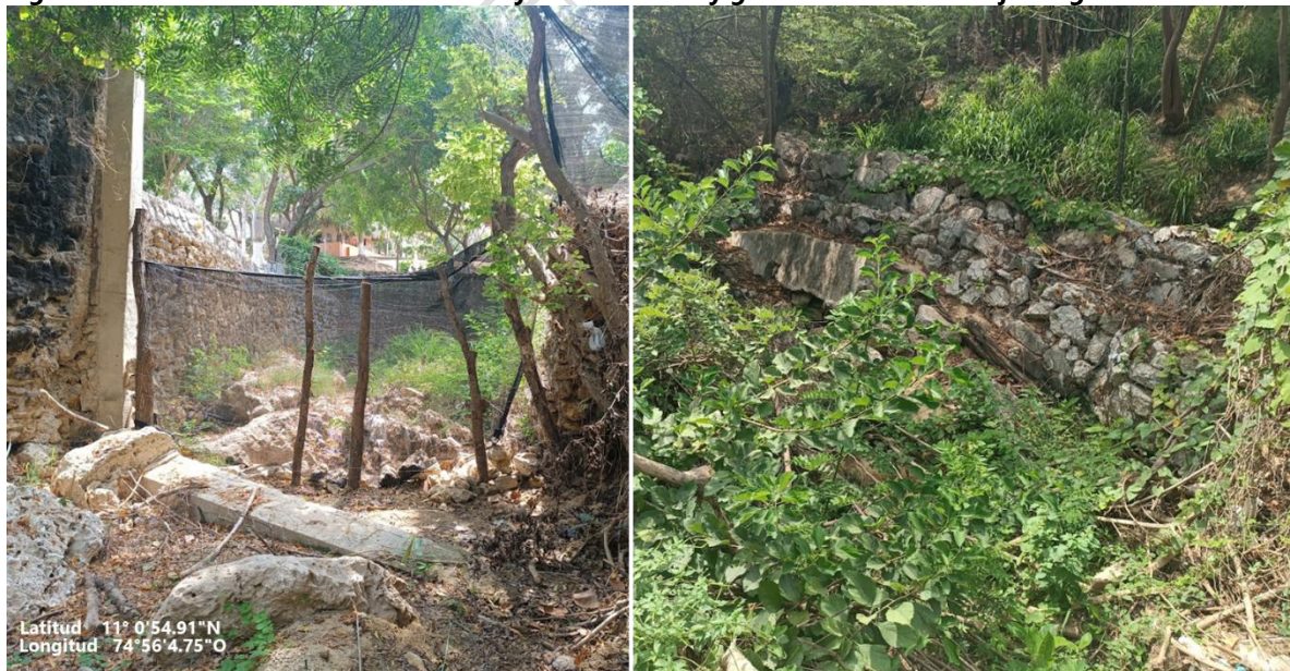
Figura 1.47. Encerramiento de cauce Arroyo San Lorenzo y gaviones Convento Hijas Sagrada Familia
