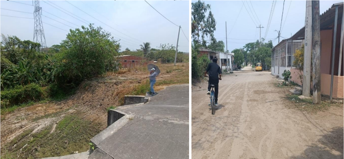
Figura 1.20. Sector Petronitas Galapa (box culvert izquierda) zona rural (derecha)
